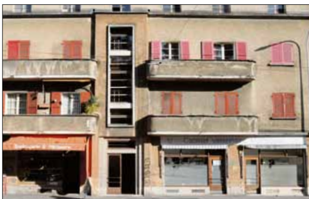
On voit d'emblée la valeur patrimoniale de ces bâtisses.
